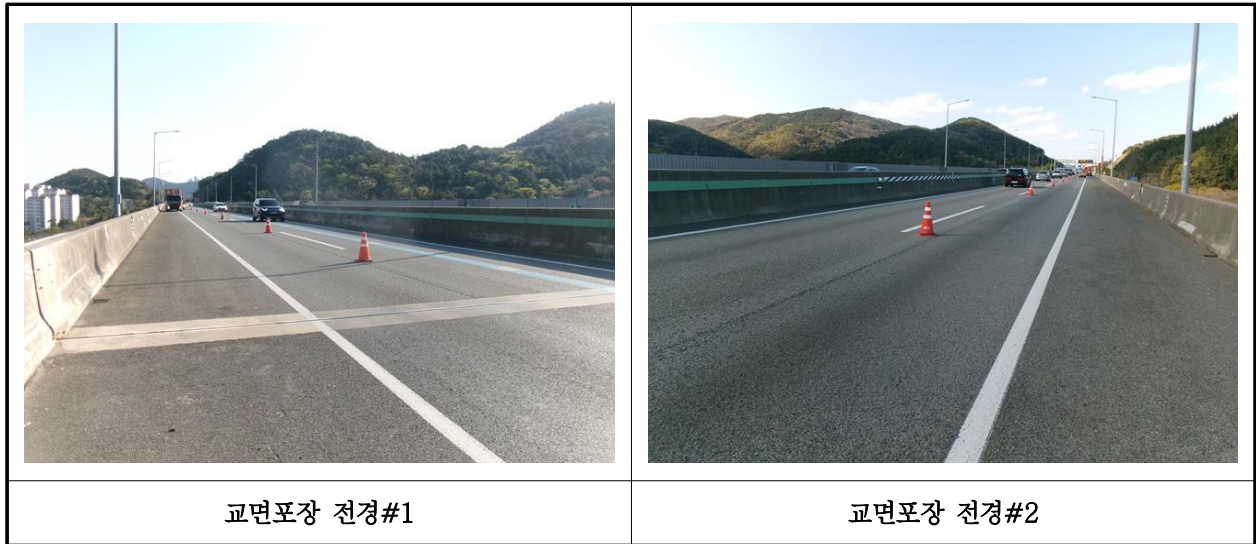
【사진 10.3.20】 교면포장 전경
