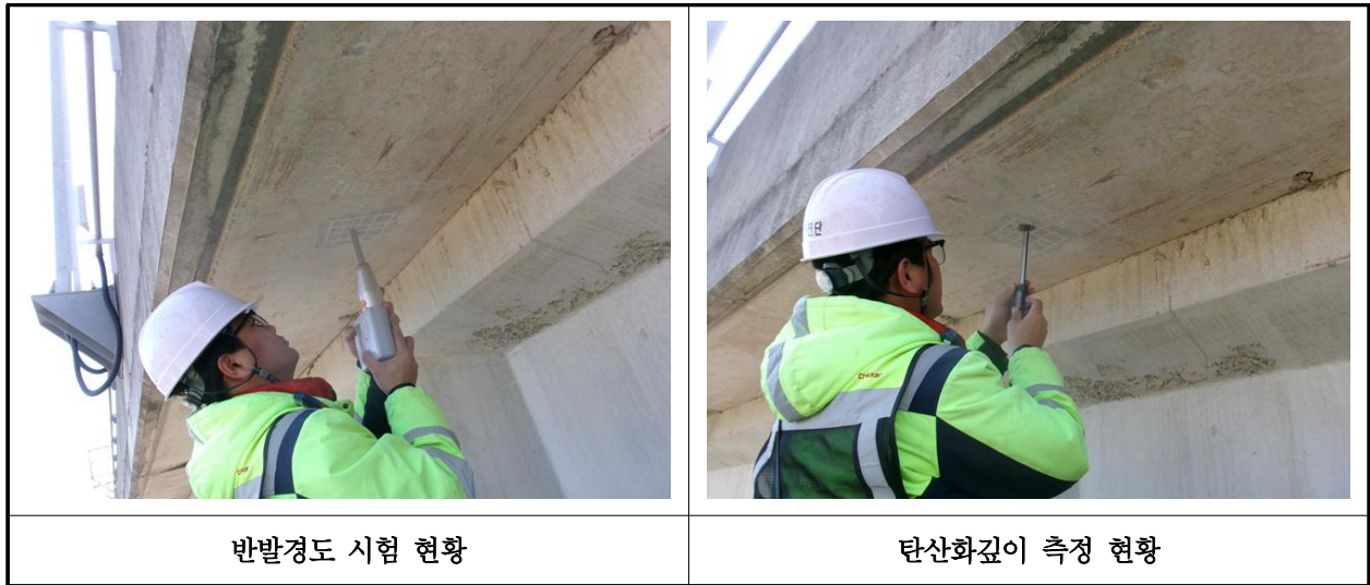
【사진 10.4.1】 콘크리트 내구성조사 현황
