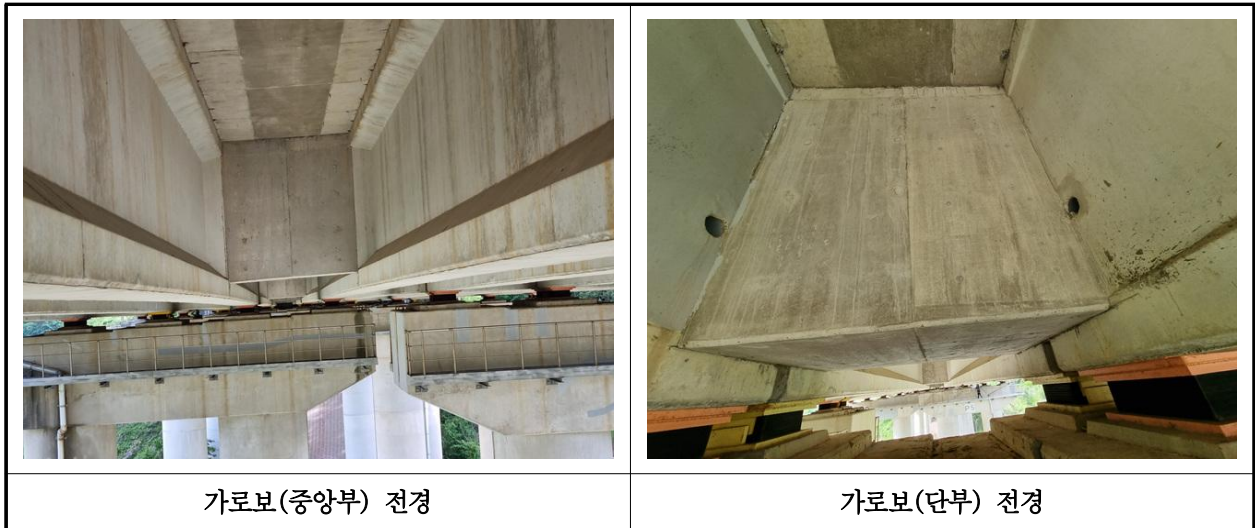
【사진 10.3.6】 가로보 전경
