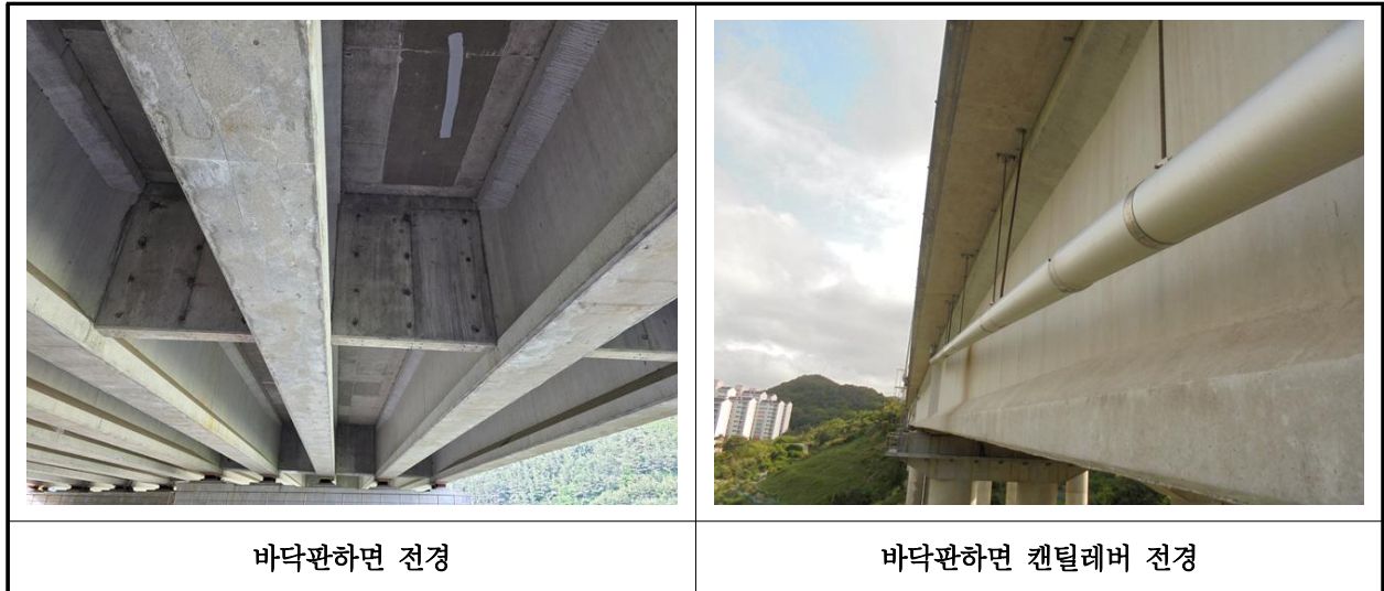
【사진 10.3.2】 바닥판하면 전경
