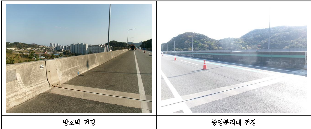
【사진 10.3.24】 방호벽 및 중분대 전경
