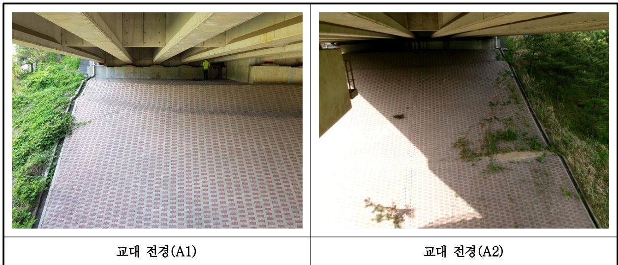
【사진 10.3.8】 교대 전경
