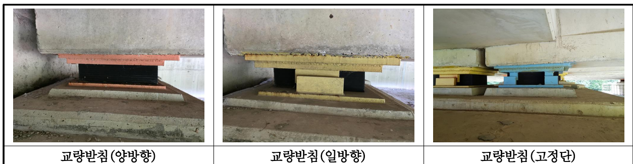
【사진 10.3.13】 교량받침 전경
