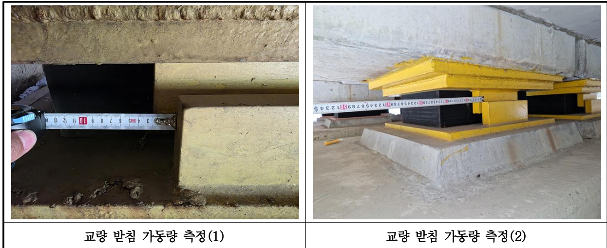
【사진 10.3.16】 교량받침 이동량 측정
