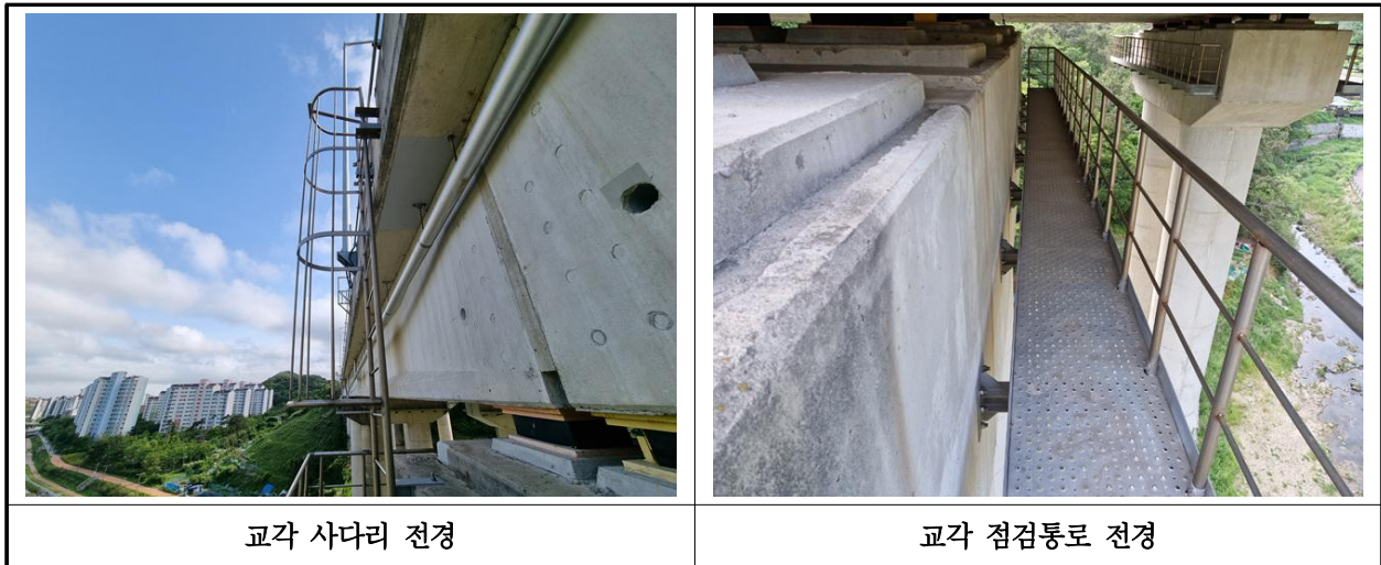
【사진 10.3.26】 교량 점검시설 전경
