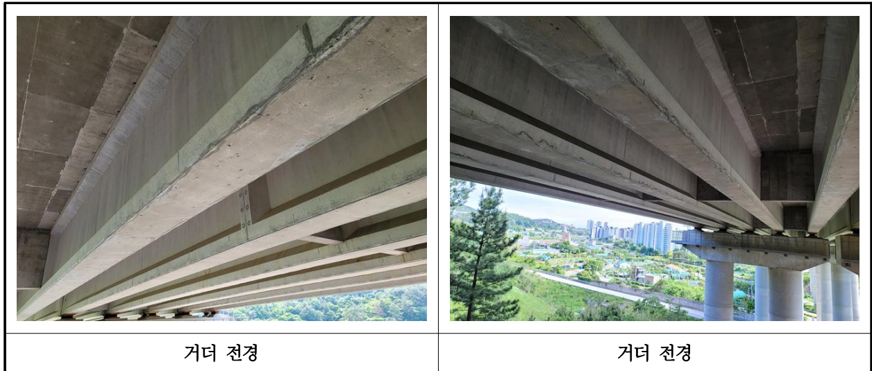
【사진 10.3.4】 거더 전경
