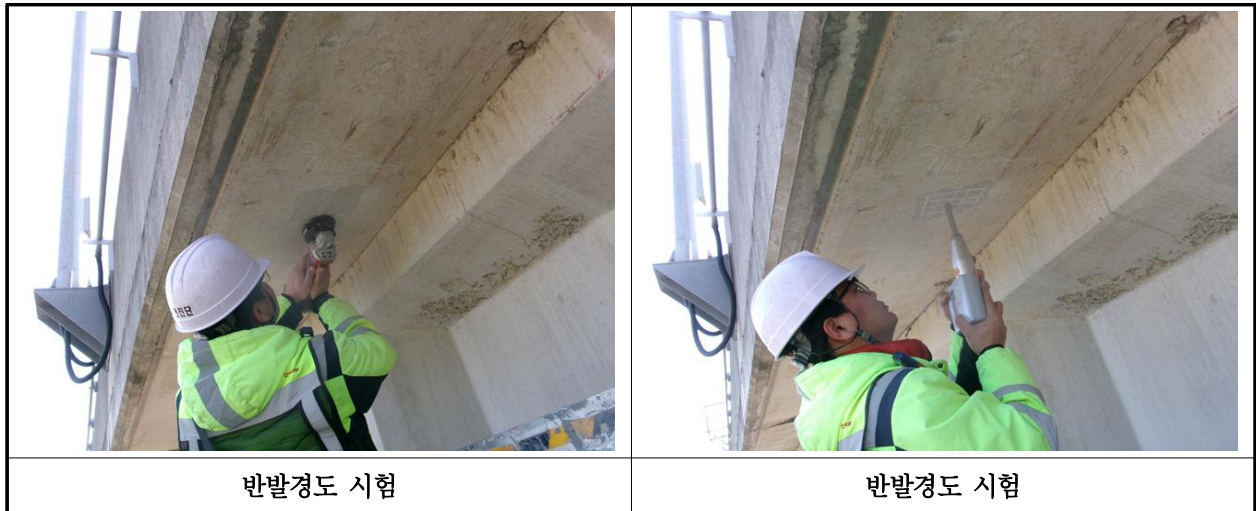
【사진 10.4.2】 반발경도시험 현장사진
