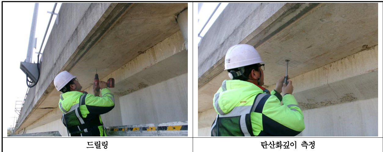
【사진 10.4.3】 탄산화 깊이 측정 현장사진
